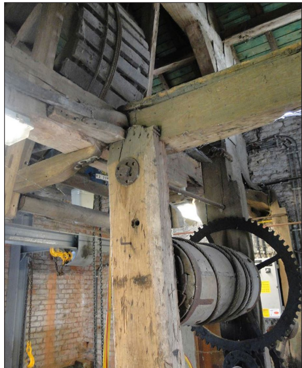
Mechanisme voor de handmatige bediening van de stuw in Geraardsbergen
