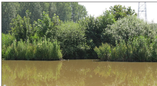
Plasbermen bevatten een natuurlijke oever, afgeschermd door breukstenen. De breukstenen breken de golfslag van de schepen. Via open zones kunnen vissen achter de breukstenen bescherming vinden tussen de planten op de achterliggende natuurlijke oever.
